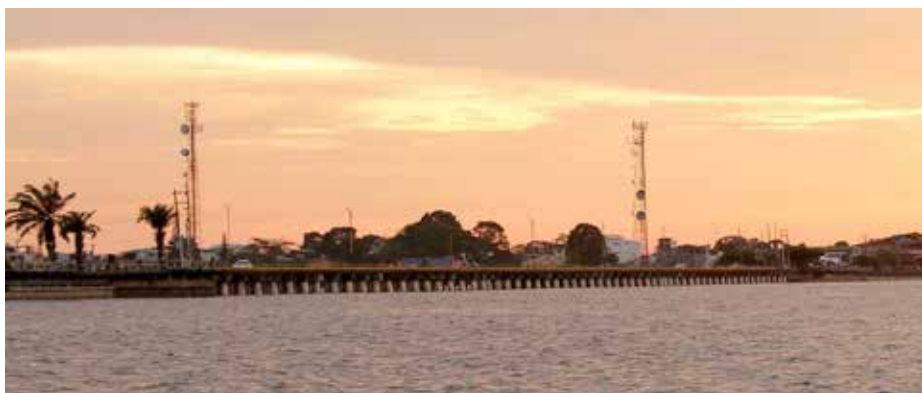
Fotografía No 2. Puente del Morro, Tumaco.
